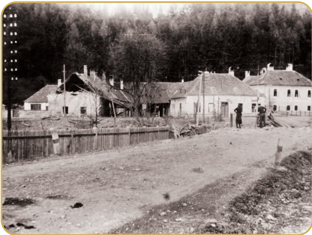
Lange Brücke nach der Sprengung 1945
