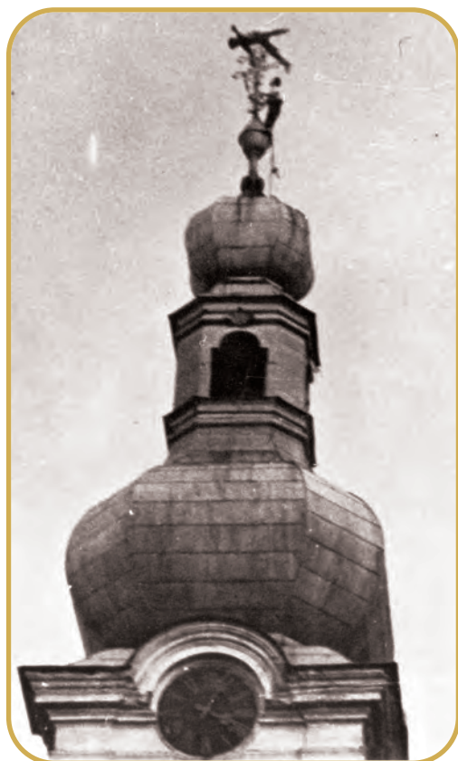
Akrobatik bei der Kirchturmrenovierung in den 50er Jahren
