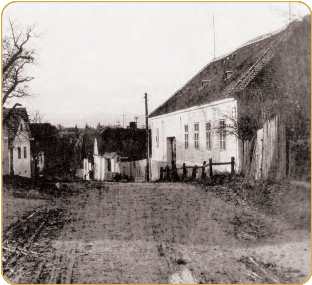
Obere Gasse in den 20er Jahren
