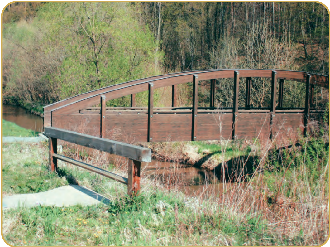
Neue, hochwassersichere Brücke
