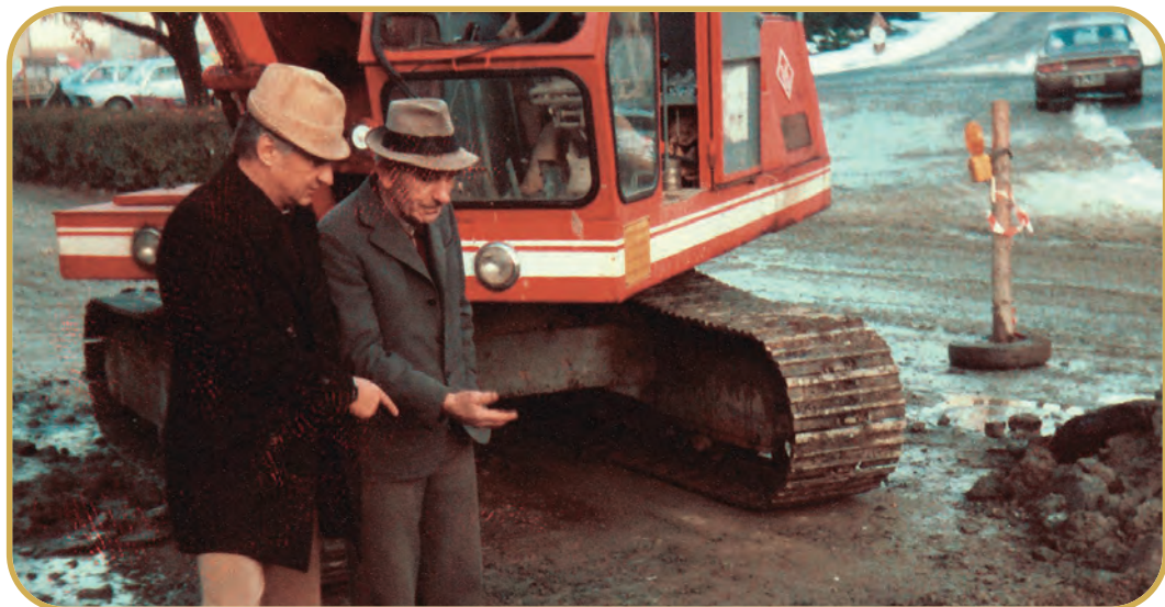
Vbgm. Nuschy und OSR Schmall inspizieren die Kanalarbeiten in der Hauptstraße 1980
