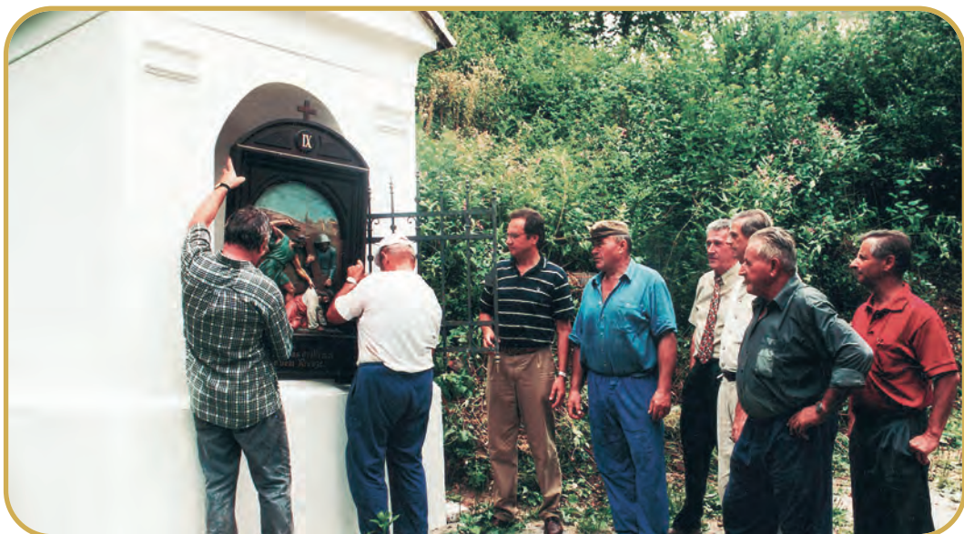
Instandsetzung der Stationen nach dem Sturm 2000
