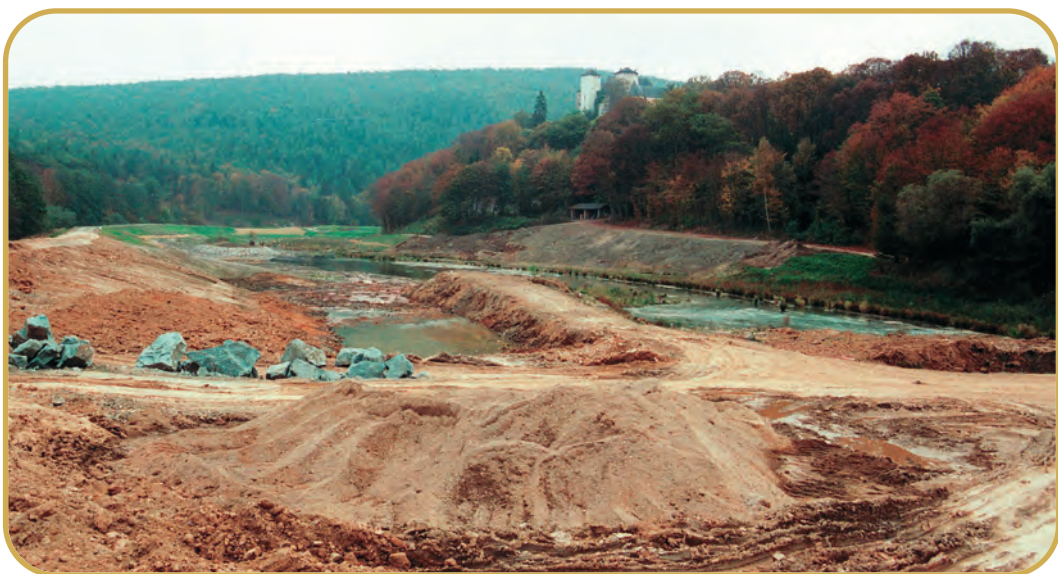
Errichtung des Rückhaltebeckens „Burgsee“ 1994-96
