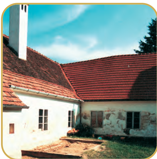
Gebäude in den frühen 90er Jahren
